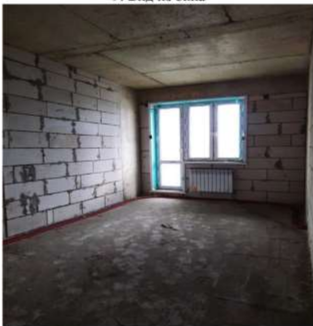
11. Помещение № 6 - жилая комната
