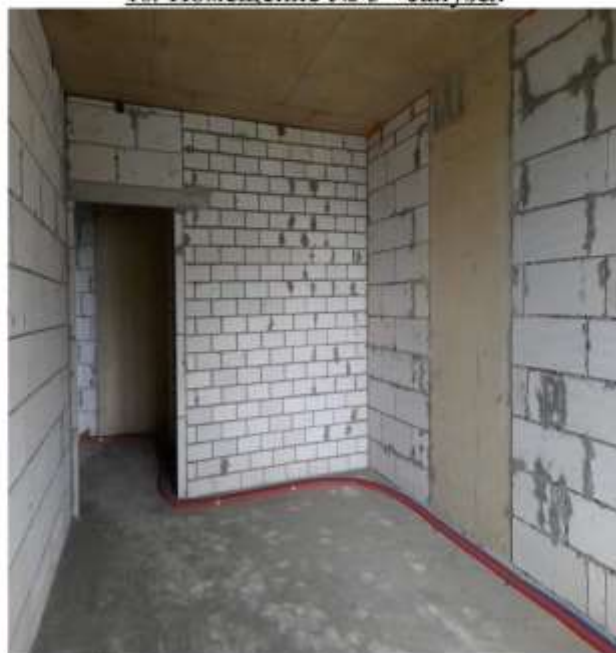
12. Помещение № 6 - жилая комната
