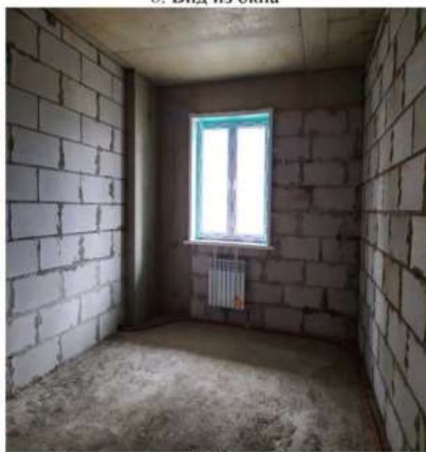
10. помещение № 5 - жилая комната
