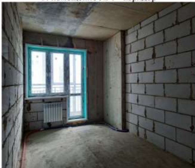
5. помещение № 3 - жилая комната
