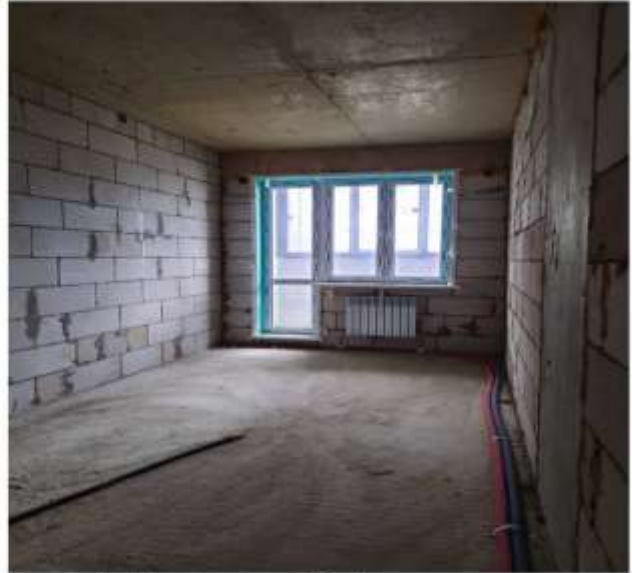
8. Помещение № 4 - жилая комната
