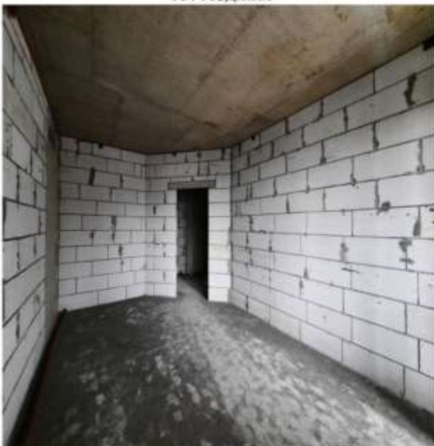
15. Помещение № 7 - жилая комната
