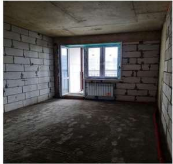
14. Помещение № 7 - жилая комната
