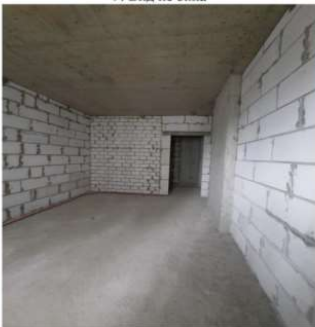
11. помещение № 5 - жилая комната
